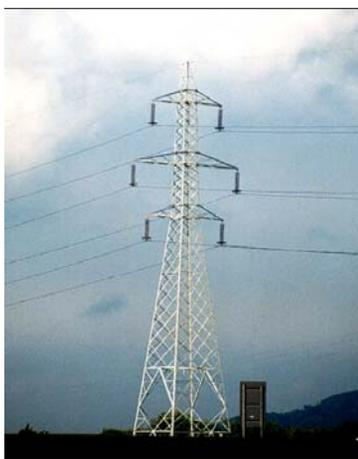
In un elettrodotto, oltre a una o due terne di conduttori attivi, possono essere presenti uno o più conduttori a potenziale nullo, che sono collegati a terra in prossimità di ogni traliccio e sono chiamati **funi di guardia**. Il loro compito è quello di proteggere i conduttori di linea contro le sovratensioni di origine atmosferica, ossia contro le scariche dovute ai fulmini.
